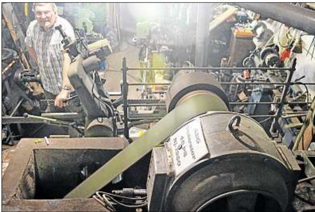
Aus dem Jahr 1950 stammt dieser Generator, der im Dietfurter Mühlenmuseum bestaunt werden kann. Eigentümer Rudi Rengnath hält den betagten Maschinenpark am Laufen. Foto: Erl
